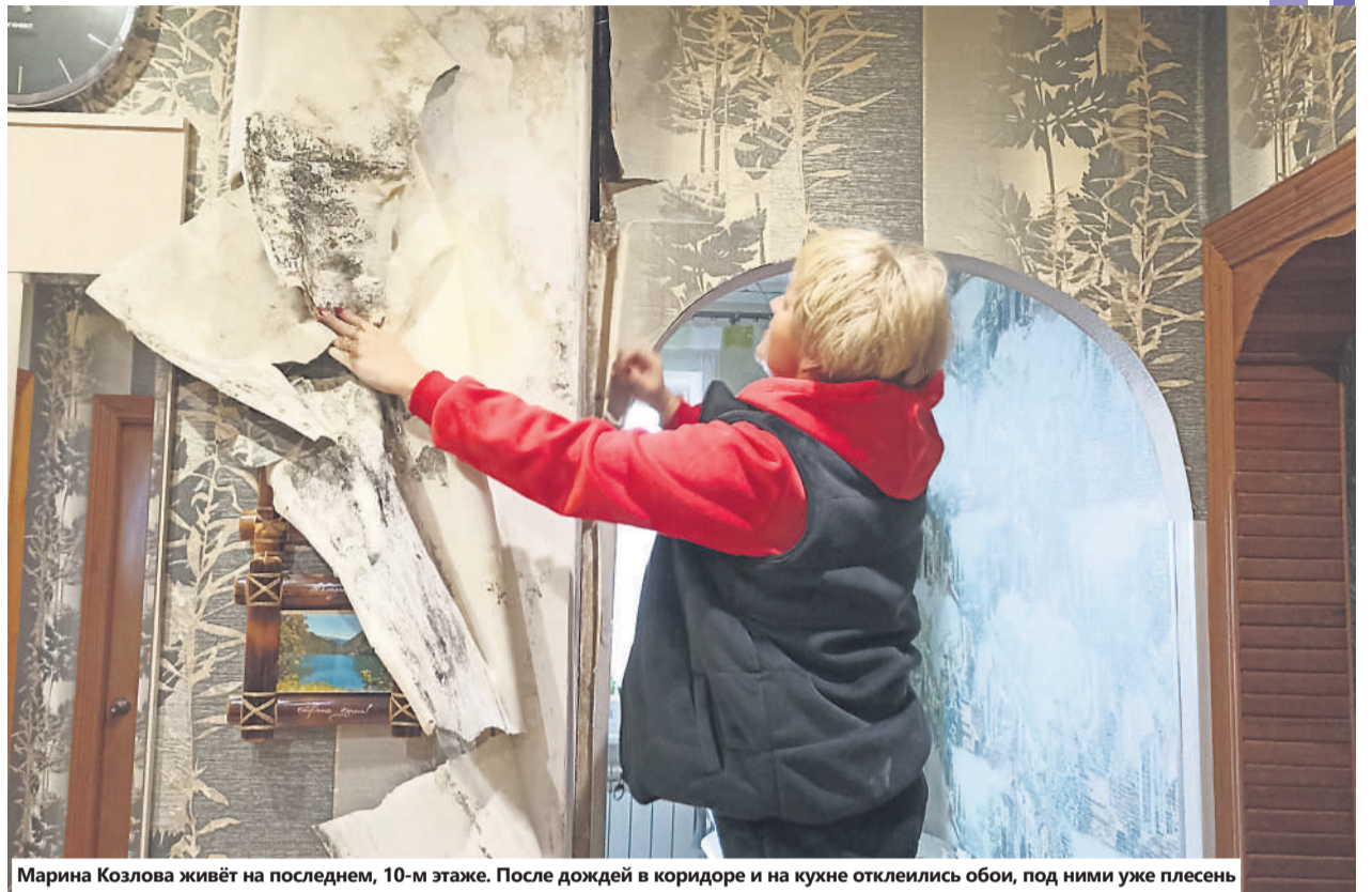
Марина Козлова живёт на последнем, 10-м этаже. После дождей в коридоре и на кухне отклеились обои, под ними уже плесень
